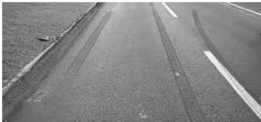
Figura 09- Marcas de frenagem no piso asfáltico
